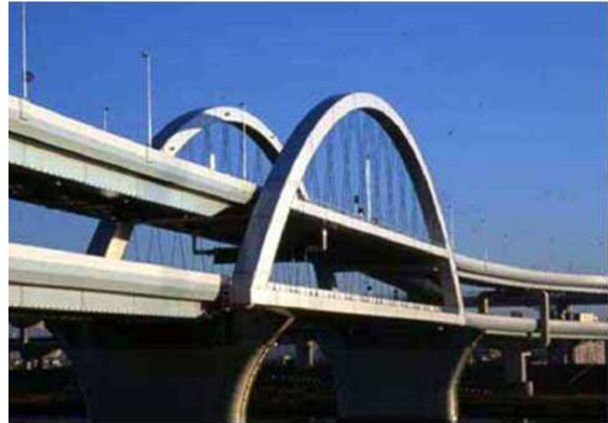
五色桜大橋 橋長: 142m 平成14年12月供用開始
