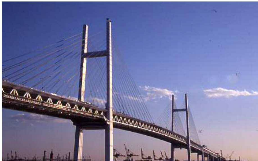
横浜ベイブリッジ 橋長: 860m 中央支間: 460m 平成元年9月供用開始
