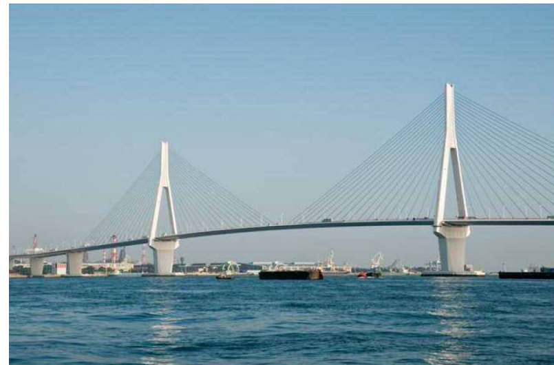
つるみつばさ橋 橋長: 1020m 中央支間: 510m 平成5年12月供用開始
