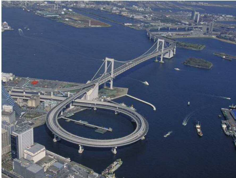
レインボーブリッジ 橋長: 798m 中央支間: 570m 平成4年8月供用開始
