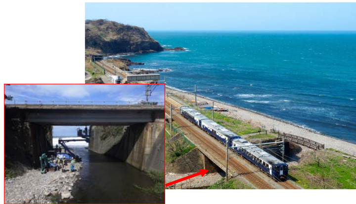
平成10年にSSI工法で補修した橋梁
