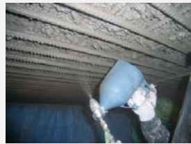
防錆ペースト塗布状況
