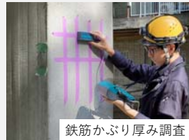
鉄筋かぶり厚み調査
