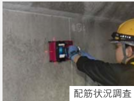
配筋状況調査
