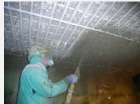
断面修復材 吹付状況
