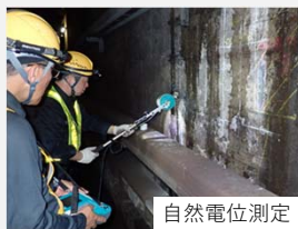
自然電位測定
