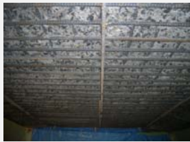
はつり・高圧洗浄後
