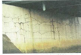
写真1 橋台のひび割れ
