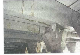
写真4 桁のひび割れ
