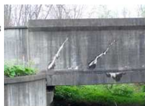
水路橋:せん断力不足
