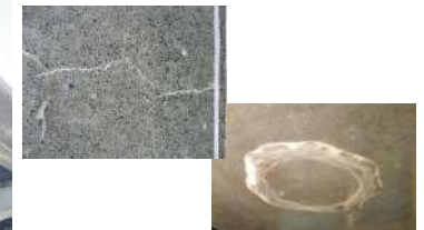
変状発生時の外観
