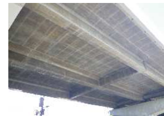
適用事例 (クリアクロス工法)
