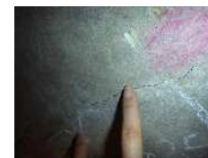
触ると段差がある
