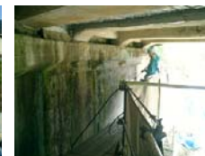
高圧洗浄(橋台)
