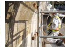
CS-21塗布(越流部)
