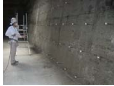
外周壁(耐震補強増厚前)
