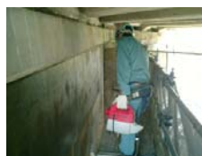
CS-21散布(橋台)
