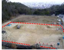
全景 (赤線枠内地下部分施工)
