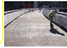
CS-21散布(堤頂)
