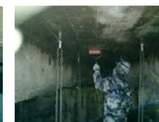
CS-21塗布(床版下面)
