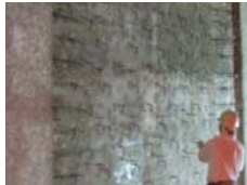
導流壁(耐震補強増厚前)
