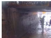
T1号橋 高圧洗浄
