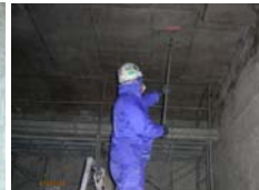
CS-21塗布(天井)
