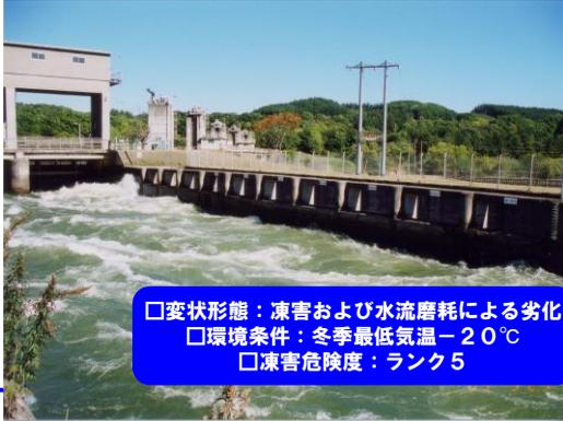
□変状形態：凍害および水流磨耗による劣化
